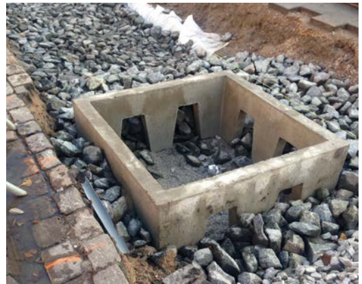
Anläggning av skelettjord. I betongfundamentet planteras trädet i det växtsubstrat som beställaren förordar. Stenskärvan utanför bildar "skelettet" och i utrymmet mellan kan trädrötterna leta sig vidare utan att löpa risk för kompakteringsskador.
