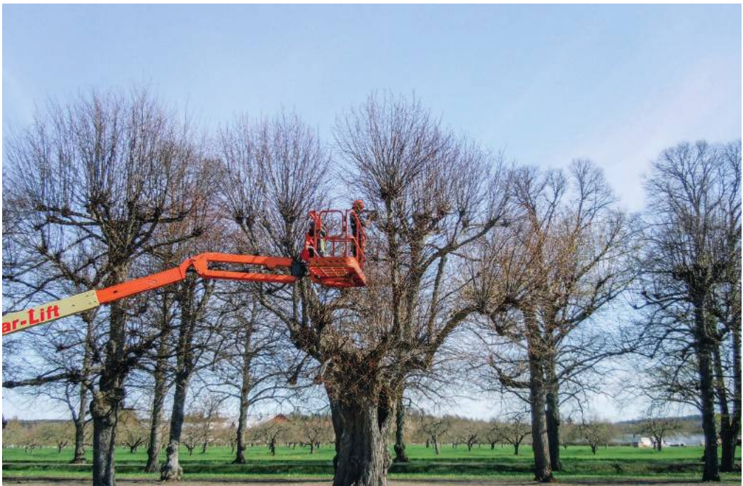
Före provbeskärningen av den första parklinden. Bild: Anders Glassel, Statens fastighetsverk, 7/5 2012.
