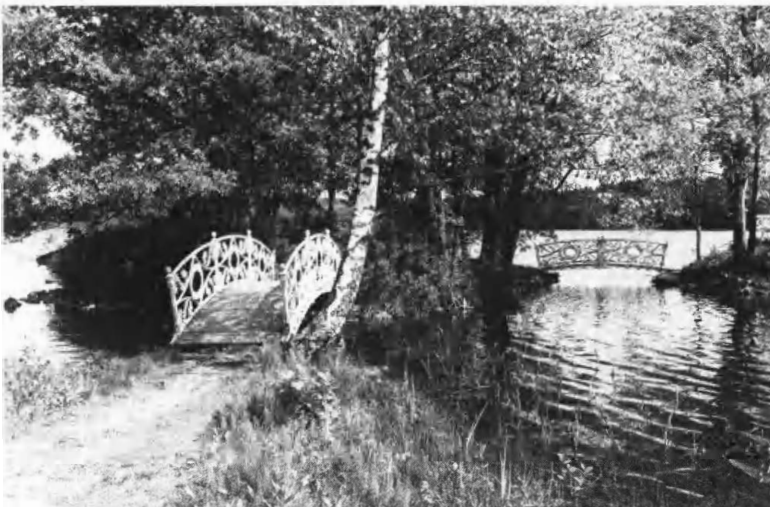
Bild 7. Broarna ut till Parasollholmarna. De små holmarna är uppbyggda av sten som bröts i parken. Broarna gjöts vid det egna järnbruket.
