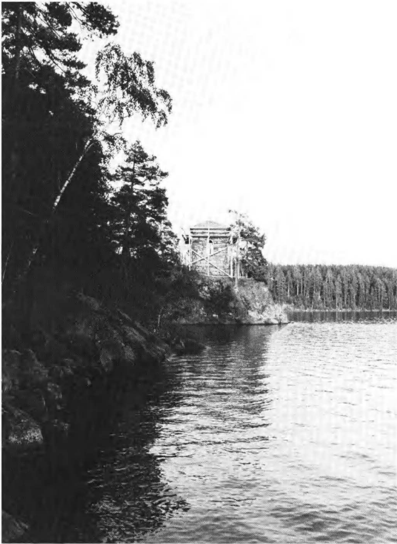
Bild 8. Stentornet vaktar på Baldernäshalvöns sydligaste udde. Byggnaden får här en välbehövlig översyn i samband med att parkens alla små byggnadsverk restaureras och repareras.
