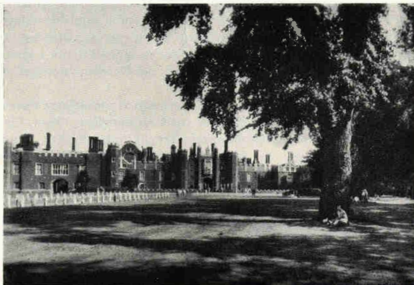
Fig. 26. Hampton Court, fasaden mot väster.
